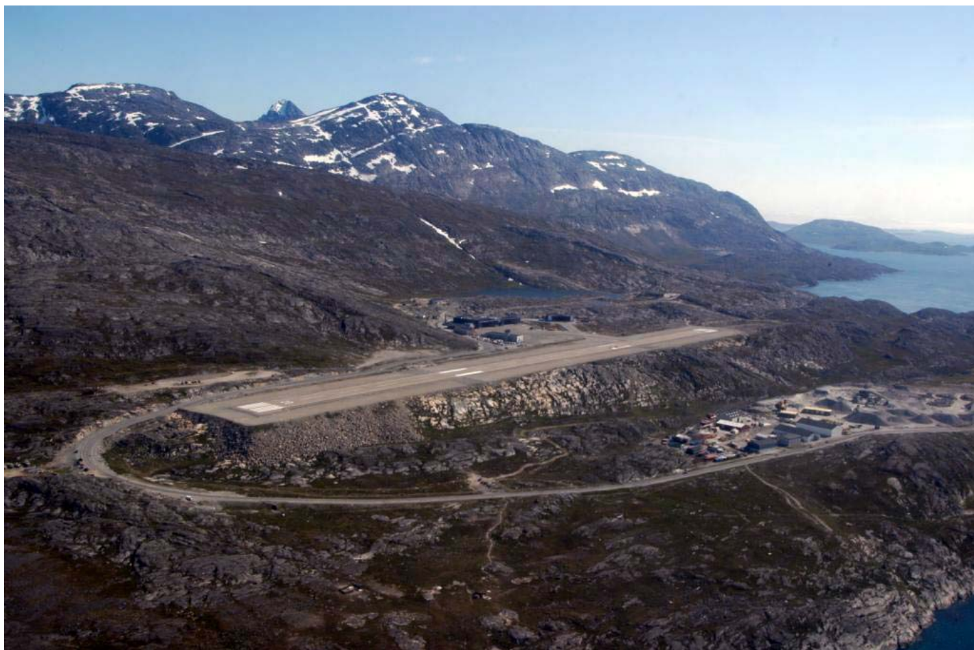
Fig 3: Eksisterende 950m bane ved Nuuk Lufthavn set fra N-V. Bemærk placeringen tæt ind til fjeld som vanskeliggør etablering af sikkerhedszoner iht. ICAO krav. Ved forlængelse til 1.799m / 2.200m gøres banen også væsentligt bredere og skrænterne bliver et betydeligt større indgreb i den eksisterende natur.
