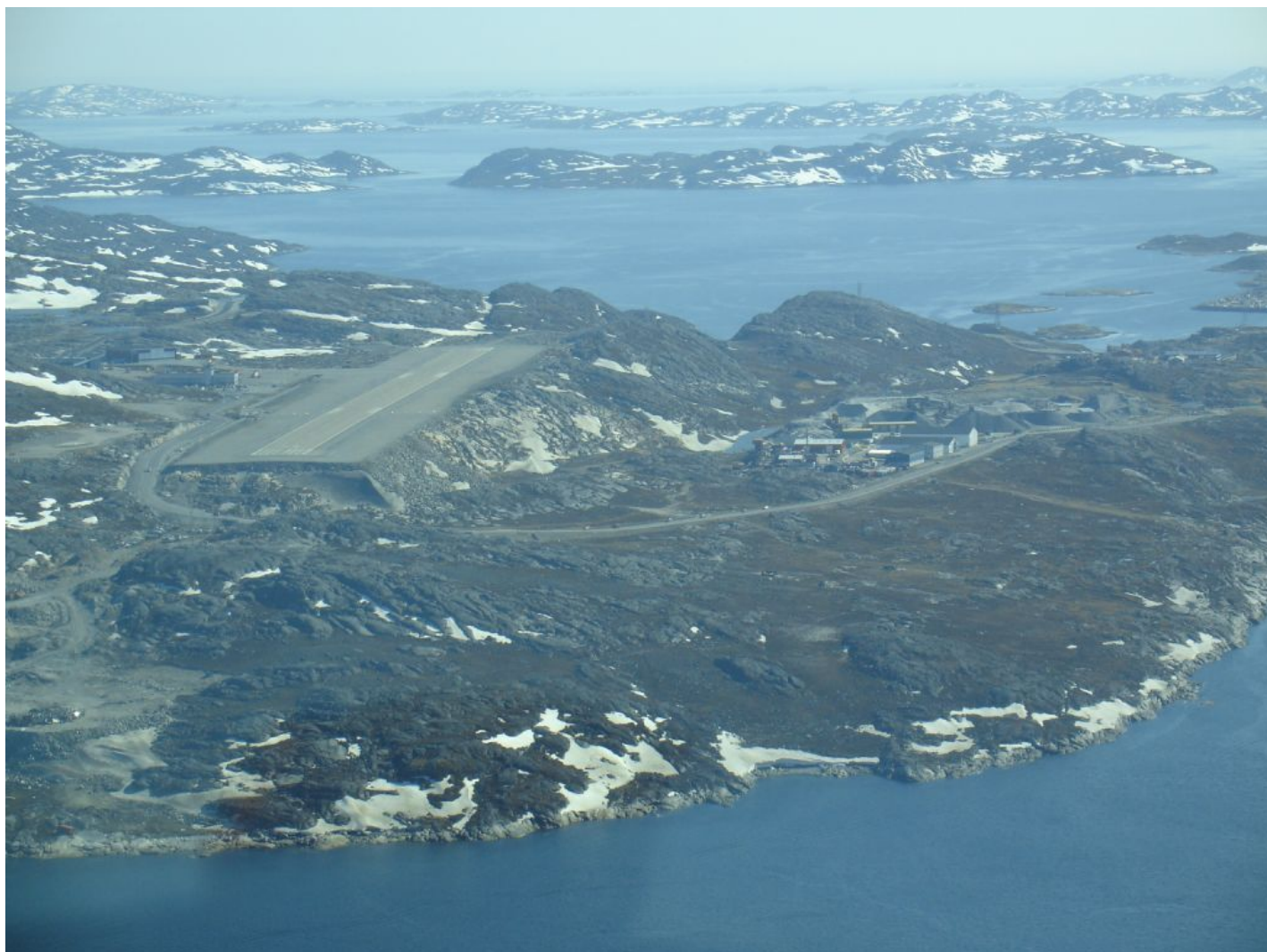
Fig 4: Eksisterende Nuuk Lufthavn set ved indflyvning fra nord. Som det ses vil forlængelse af banen betyde endog meget høje skrænter og op til 80-85m høje fundamenter til banelys. Skal ICAO's krav til sikkerhedsafstande opfyldes vil det betyde bortsprængning af store områder af Lille Malene. Bortsprængning af disse arealer er ikke medregnet i det prisforslag der ligger til grund for det forslag der efterår 2007/ forår 2008 behandles politisk af landstinget. Øvrige forslag til placering af lufthavnen opfylder ICAO's krav om sikkerhedsafstande, herunder forslaget til en 3.000m bane på Angisunnguaq.
