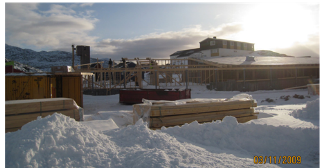
Fra byggepladsen - billeder af det færdige byggeri er på vej.
