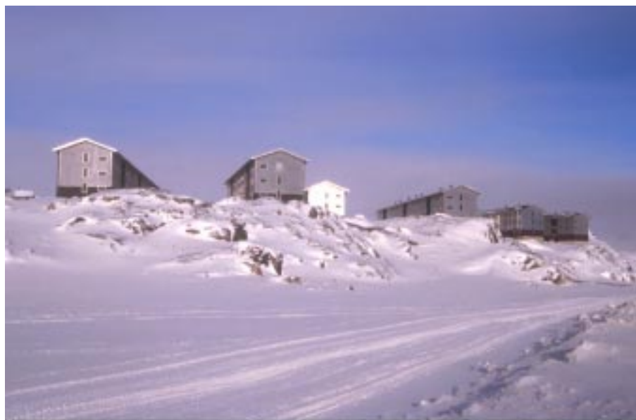
Qernertunnguit/ Antenneområdet. Facade udført i alu-plader.
